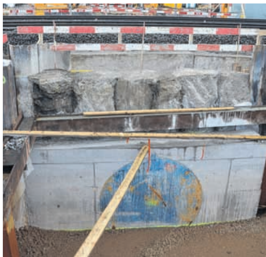
Von der Seeseite gesehen wird der Mikrotunnel hier durchgebrochen.
